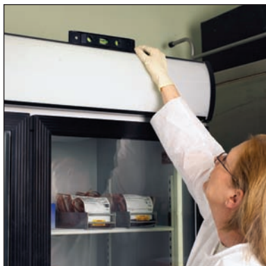
Использование спиртового уровня для проверки правильности установки холодильника
