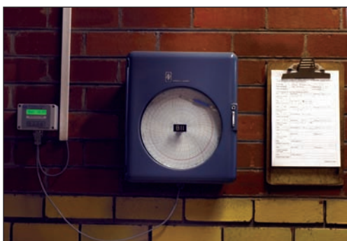
Термограф, непрерывно регистрирующий температуру в течение семи дней.
